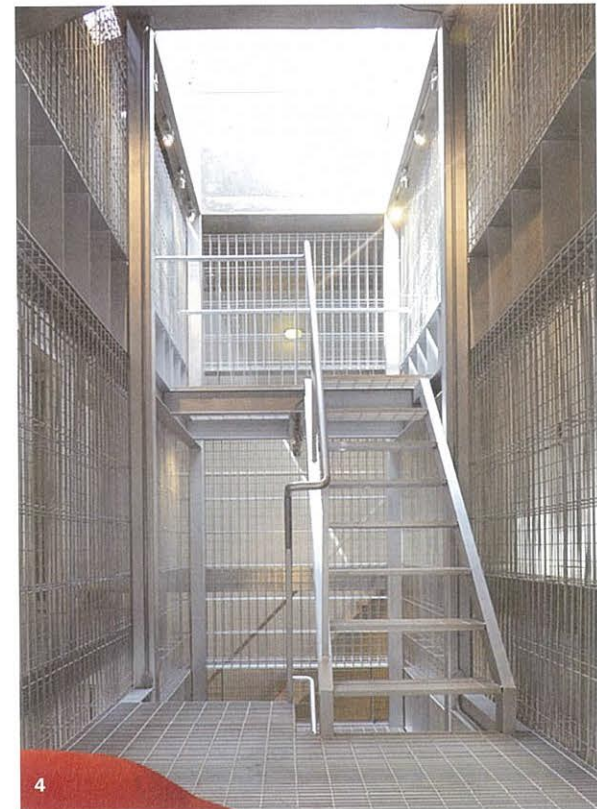
3 建築立面 4 網格形式的書架，讓自然光滲透到室內 5、6 學生住宿空間 7 學生住宿空間，包含衛浴空間
